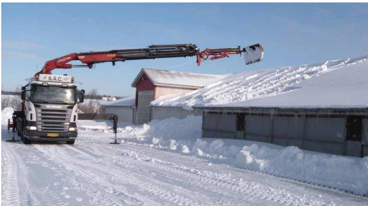
Sne fjernes fra taget af vognmandsfirma. På denne måde er der ingen risiko for, at personer falder ned.
