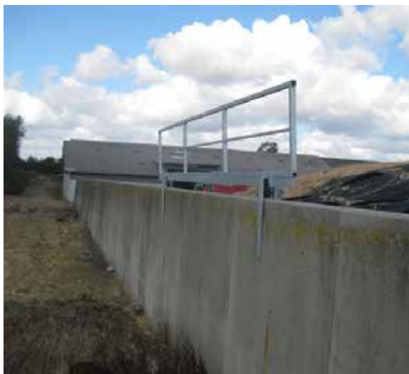
Flytbart rækværk med hjul, der let køre hen ad siloens kant i takt med, at siloen tømmes. Rækværk flyttes let med pallegafler til anden silo.
