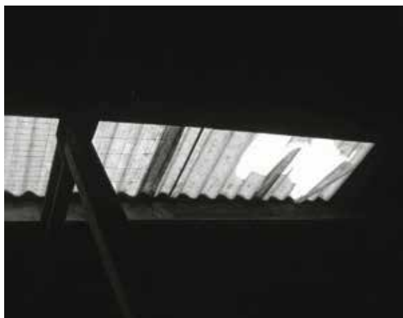
Her faldt en landmand gennem taget. Det kunne være forhindret ved at dække lyspladerne over.
