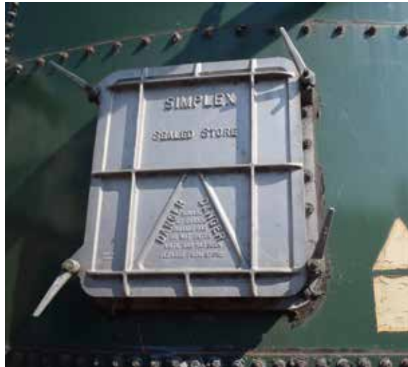
Mandeluge på gastæt silo med advarsel om CO 2 -gas og påbud om at tilføre ilt før man går ind.
